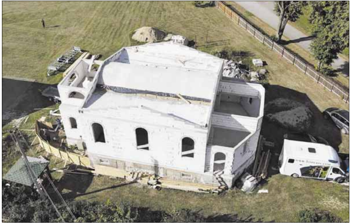
▶ Строящийся в Шальчининкае храм в честь святителя Тихона нуждается в пожертвованиях. Фото из приходского архива
